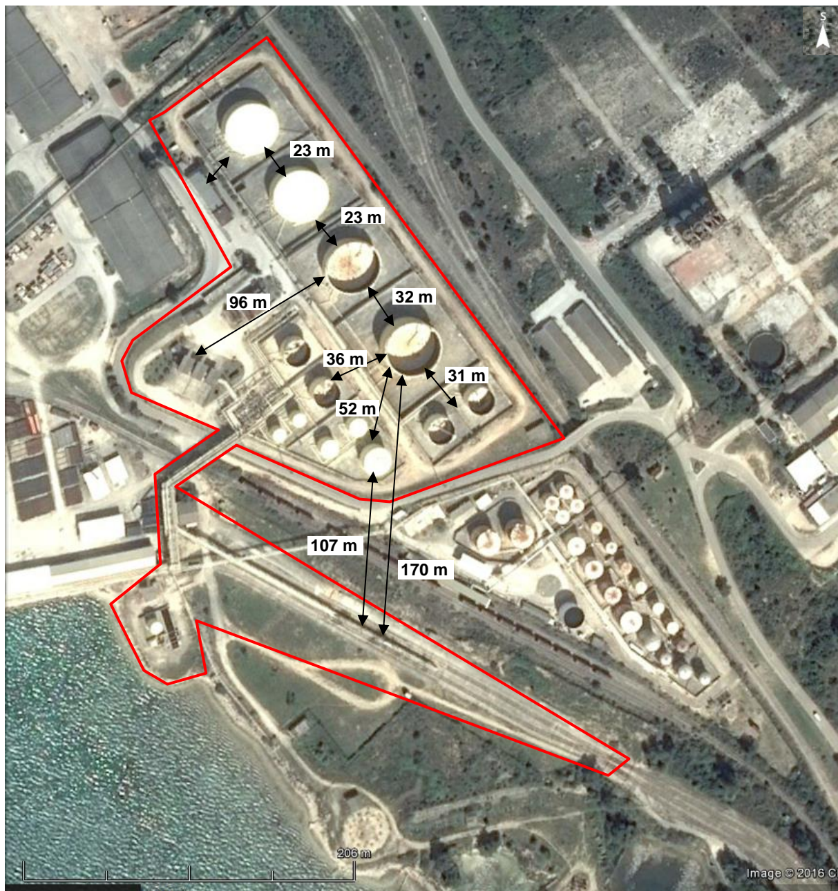
Slika 10. Međusobna udaljenost objekata (djelova postrojenja) na području postrojenja TTTR koji predstavljaju najveće opasnosti na lokaciji
